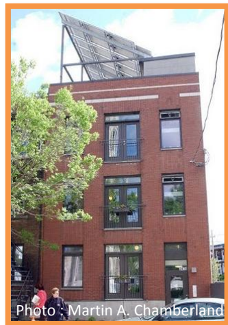
Environnement et modernité : Triplex Zéro Énergie à Verdun.
